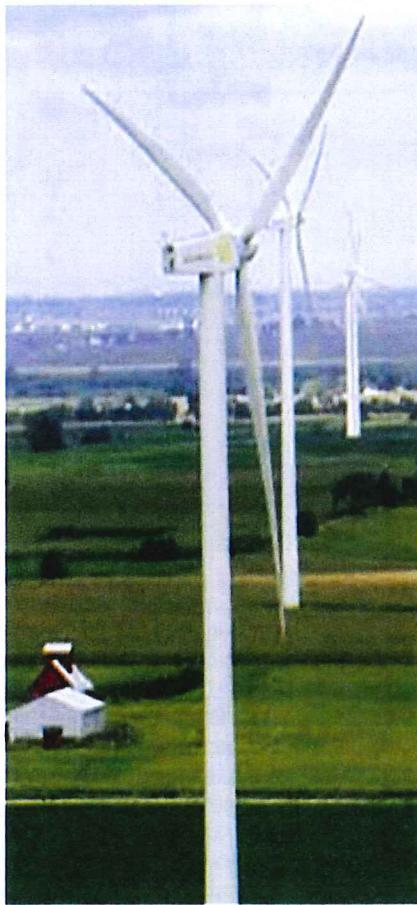
**Проектом реконструкции автодороги М-4 «Дон» км 1024 — км 1091 предусматривается строительство двух ветроэлектростанций (ВЭС) мощностью 4,25 и 2,55 МВт каждая, соответственно с 5 и 3 ветроэнергетическими установками (ВЭУ) единичной мощностью по 850 кВт.**
